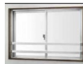
転落防止の手すりの設置
